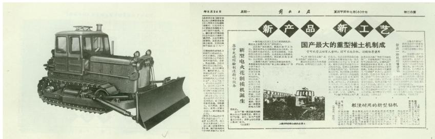
1964年6月当时国内最大型的推土机上海100型推土机试制成功
